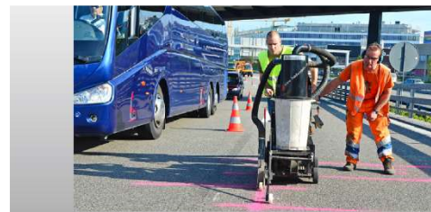
Schritt 1: In den Strassenbelag werden Schlitzfräse gebohrt.
