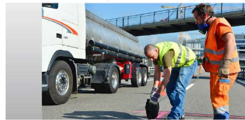
Schritt 4: Die Schlitzfräse werden mit heissem Bitumen wieder vergossen.
