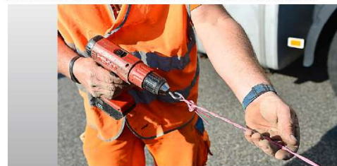
Schritt 3: Ausserhalb der Schleife soll kein Magnetfeld mehr entstehen. Deshalb werden die Drähte, die Schleife und Zählgerät verbinden, verdrillt.
