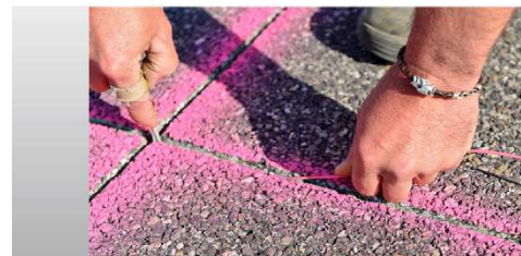
Schritt 2: In die Schlitzfräse wird Kupferdraht eingelegt. Es braucht pro Schleife vier Windungen, damit ein Magnetfeld entsteht.
