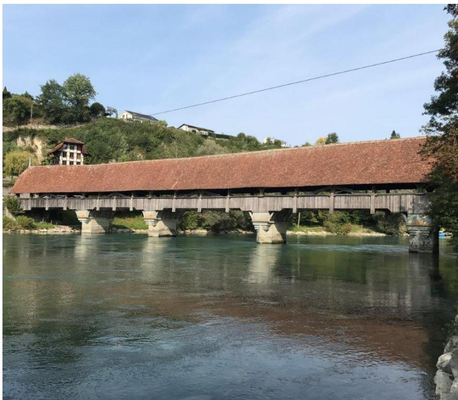
Die Neubrügg (Neubrücke) verbindet seit fast 500 Jahren die Gemeinde Kirchlindach mit dem Neufeld-Quartier. Im Juli 2025 musste sie aus Sicherheitsgründen gesperrt werden. Untersuchungen im Rahmen der geplanten Sanierung zeigten, dass sich Schäden an den unteren Holzteilen schneller als erwartet entwickelt haben: Mehrere Träger sind durch Feuchtigkeit und Belastung stark geschwächt und müssen ersetzt werden.
