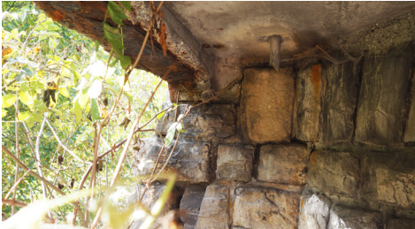
Rostschäden an Brückenträgern
