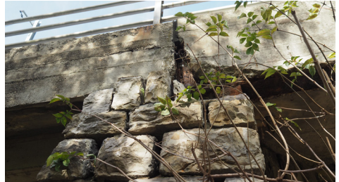
Schadhafte Brückenplatte
